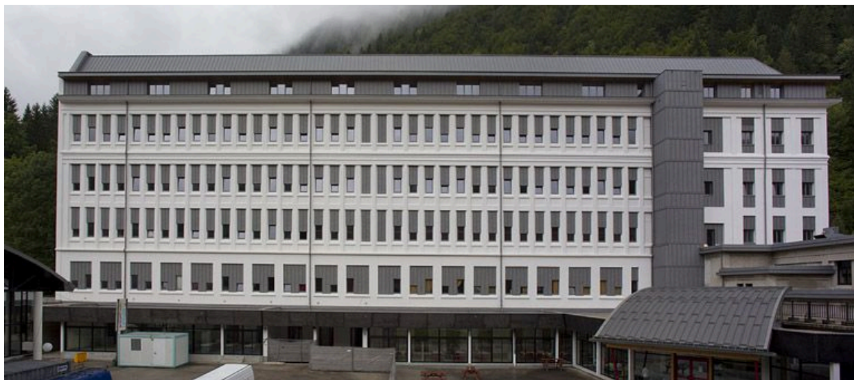
Bâtiment D : façade sur la cour (ouest), après restauration.
