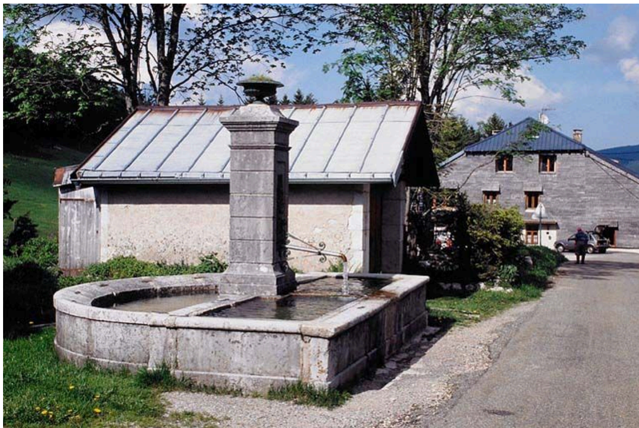
Vue générale de la fontaine.
