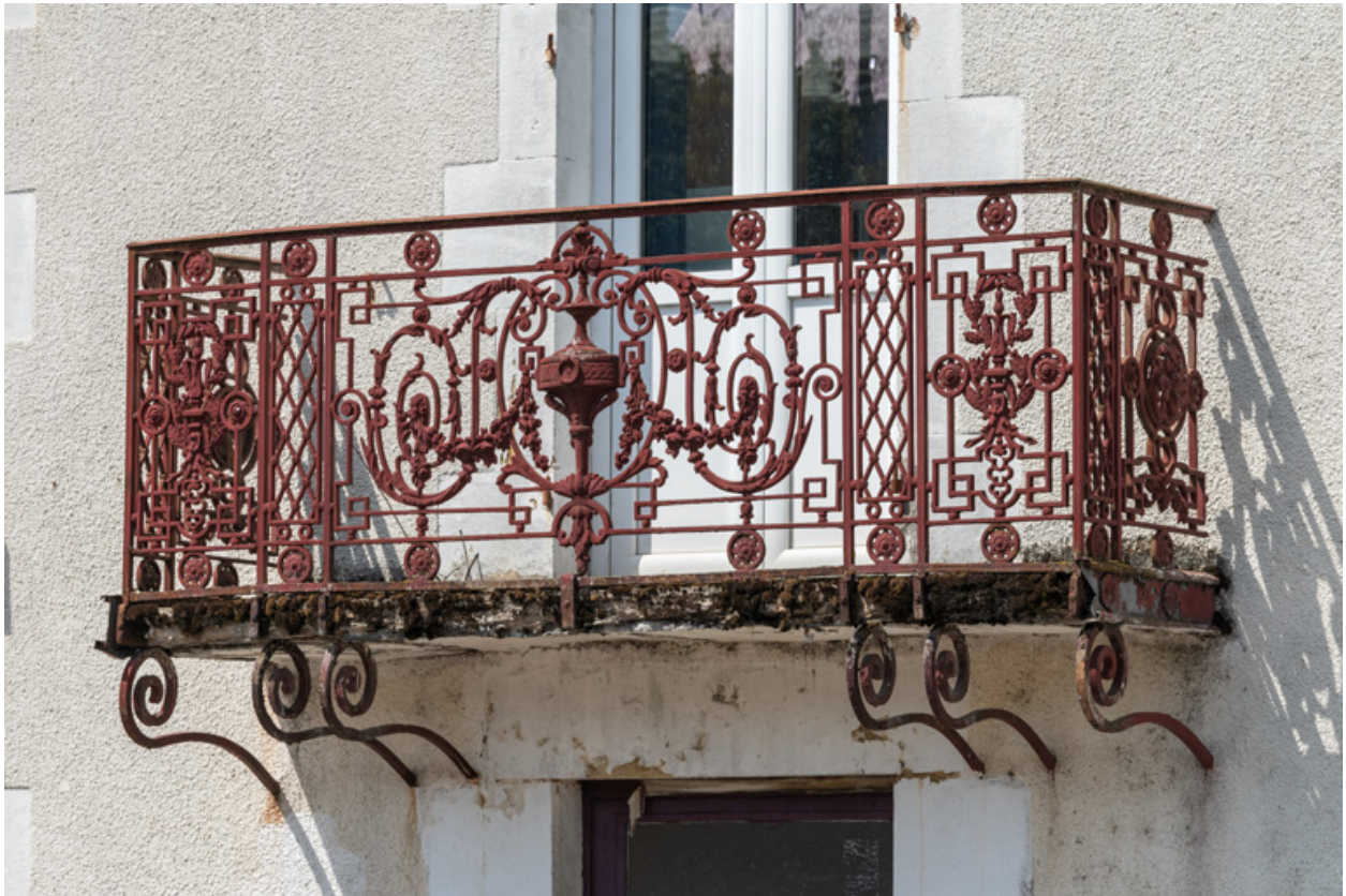
Balcon de la travée centrale de la partie sud, vue de trois-quarts.
