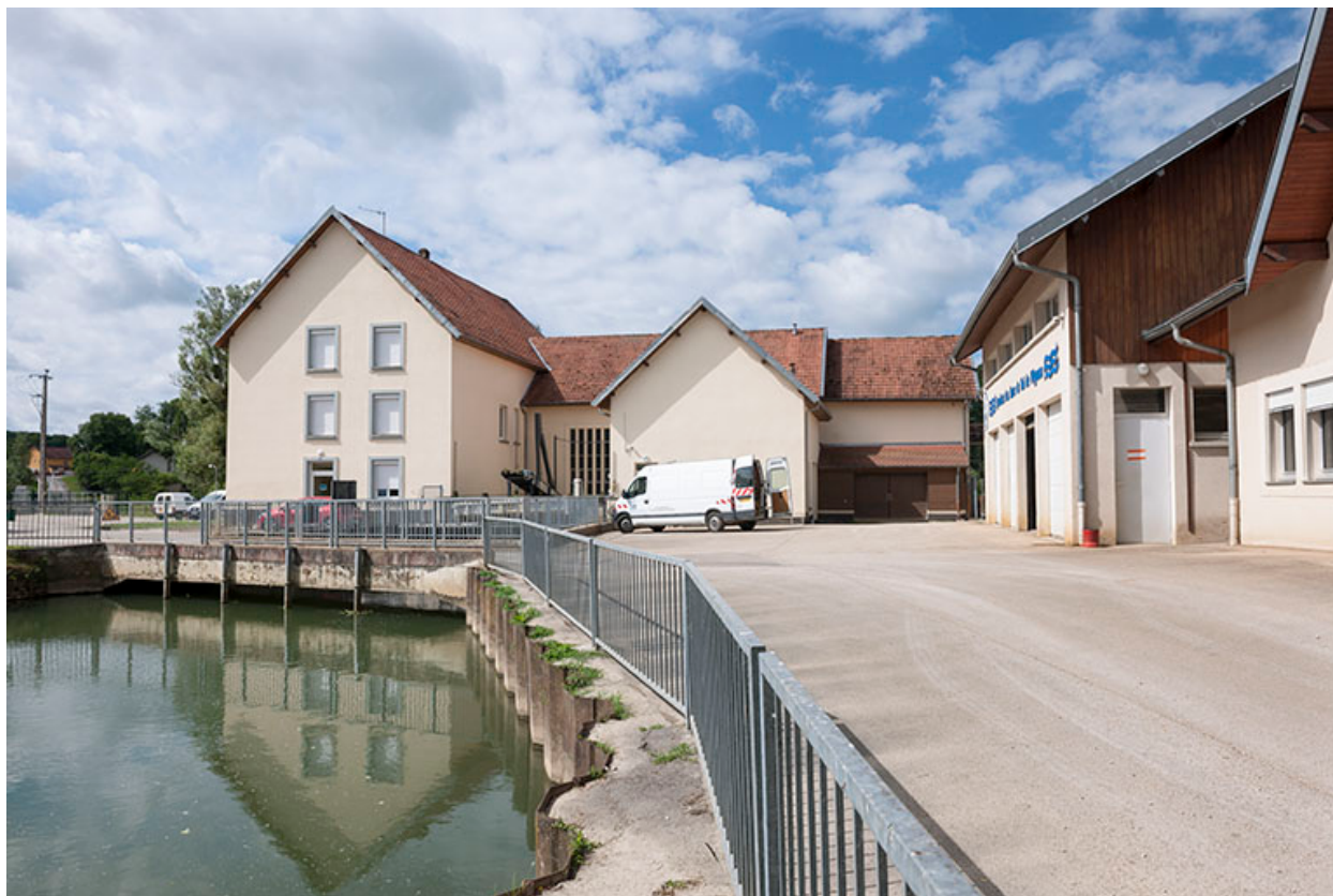
La centrale hydroélectrique vue depuis le nord.
