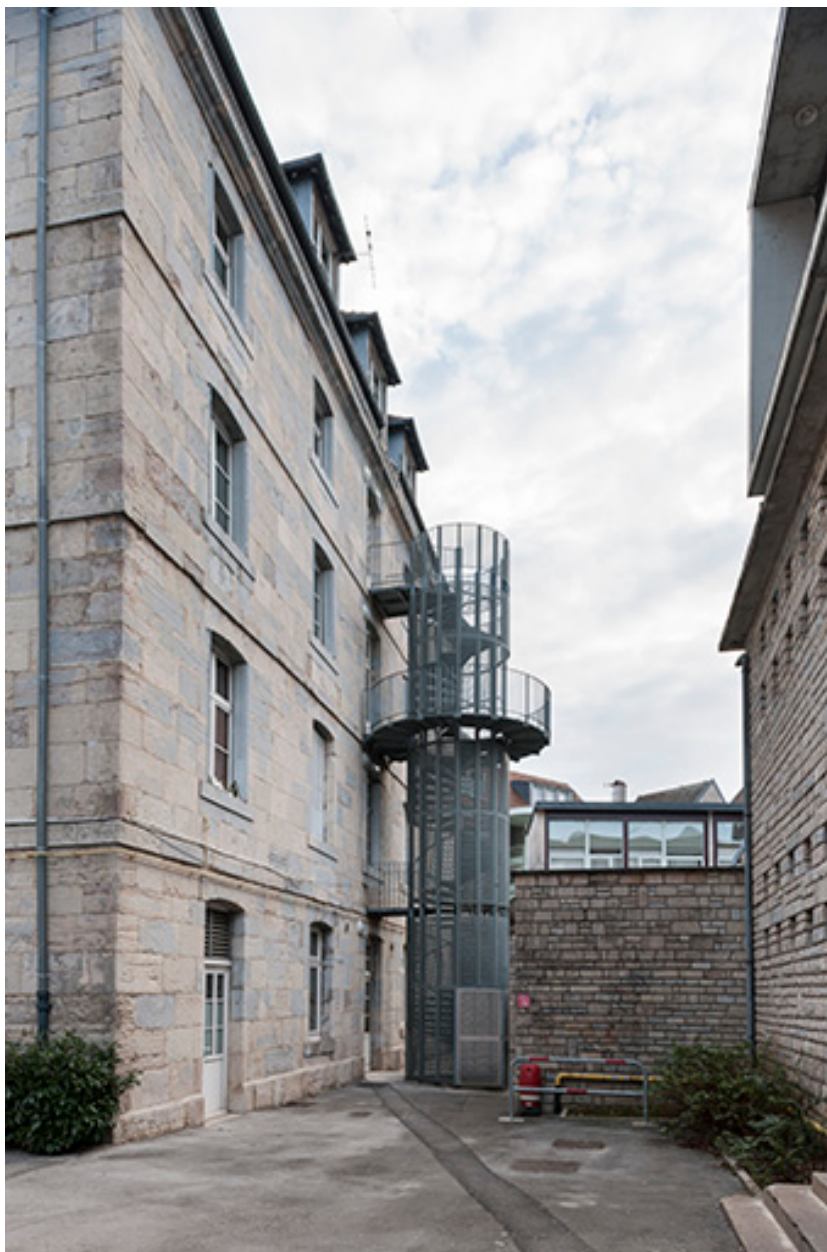
Escalier de distribution extérieur du pavillon est.
