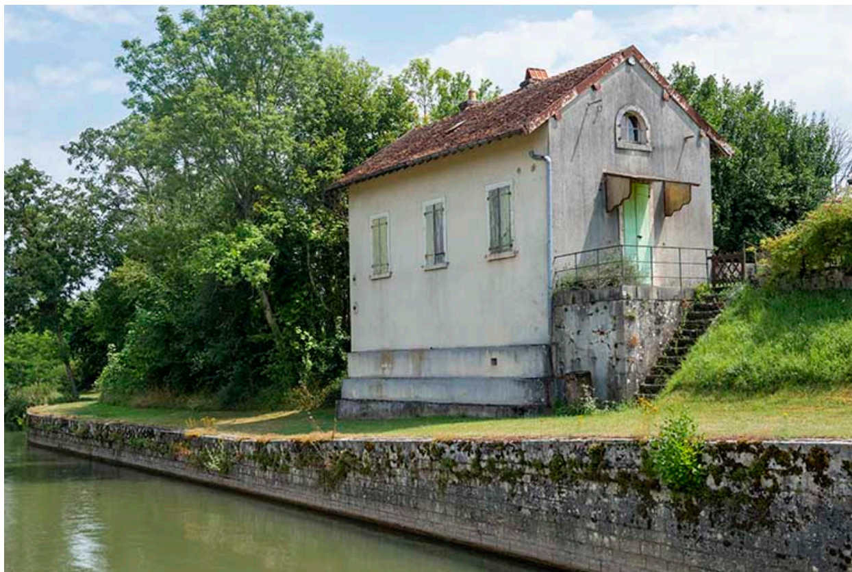
Maison de la porte de garde à Charentenay (70).
