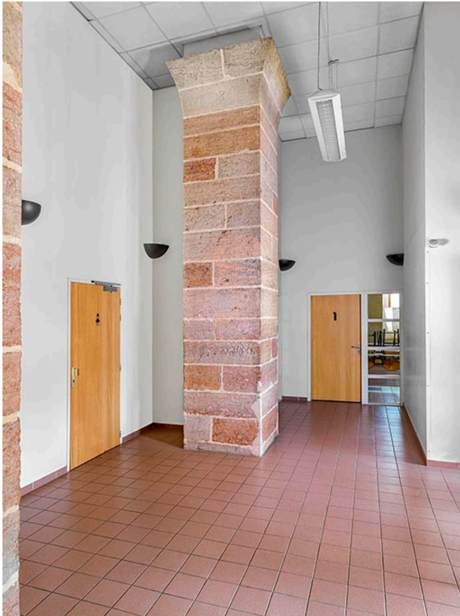
Détail d'un des piliers.
