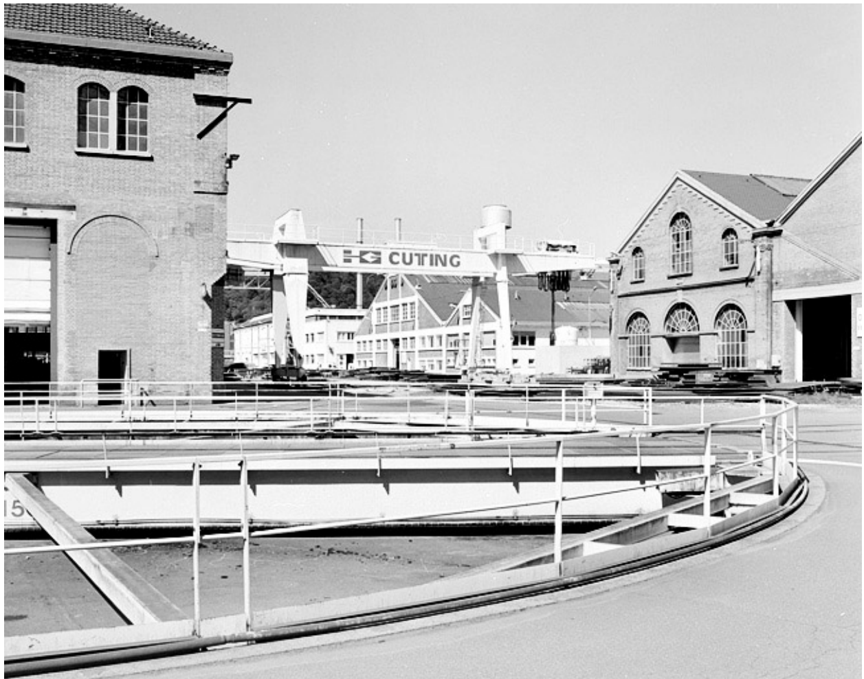
Vue d'ensemble depuis la plaque tournante : pont roulant et ateliers de métallurgie.
