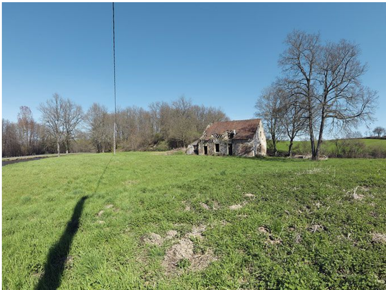
La maison éclusière.
