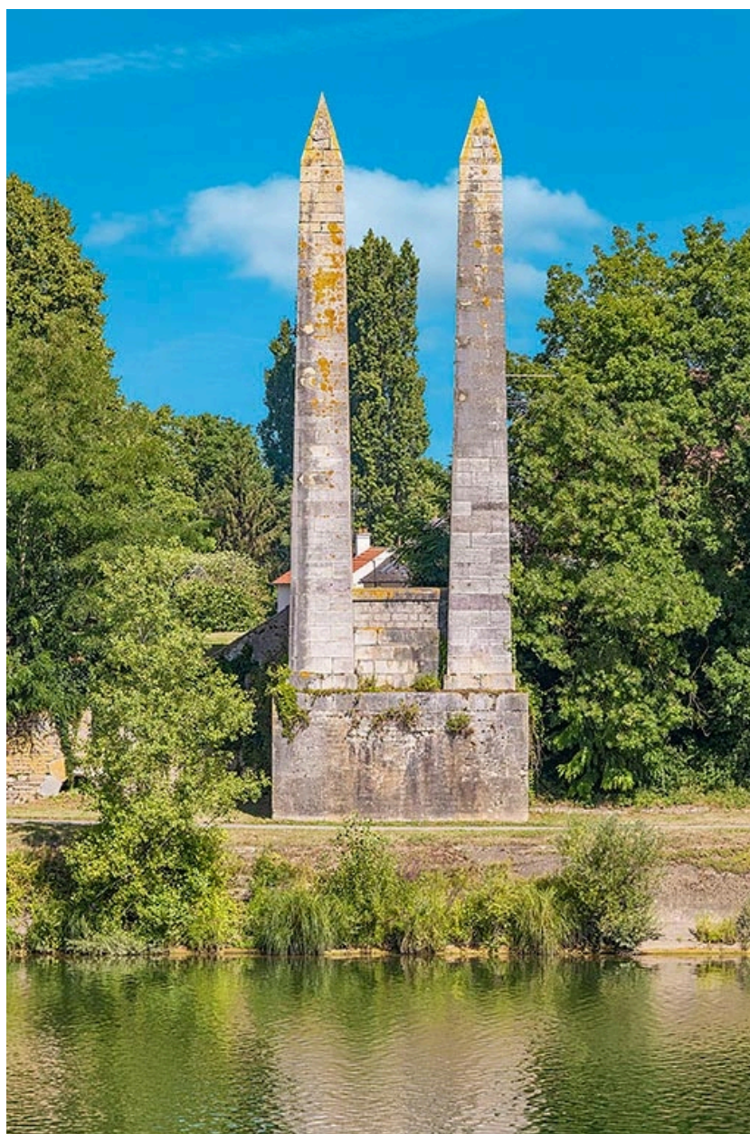
Pylônes de la rive droite.
