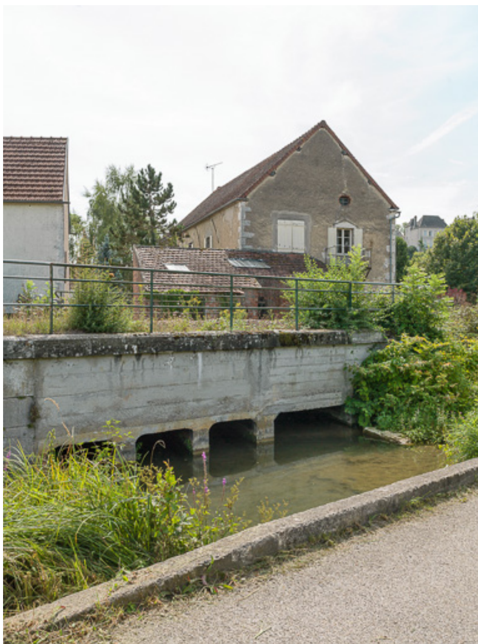
Vue de l'aqueduc.
