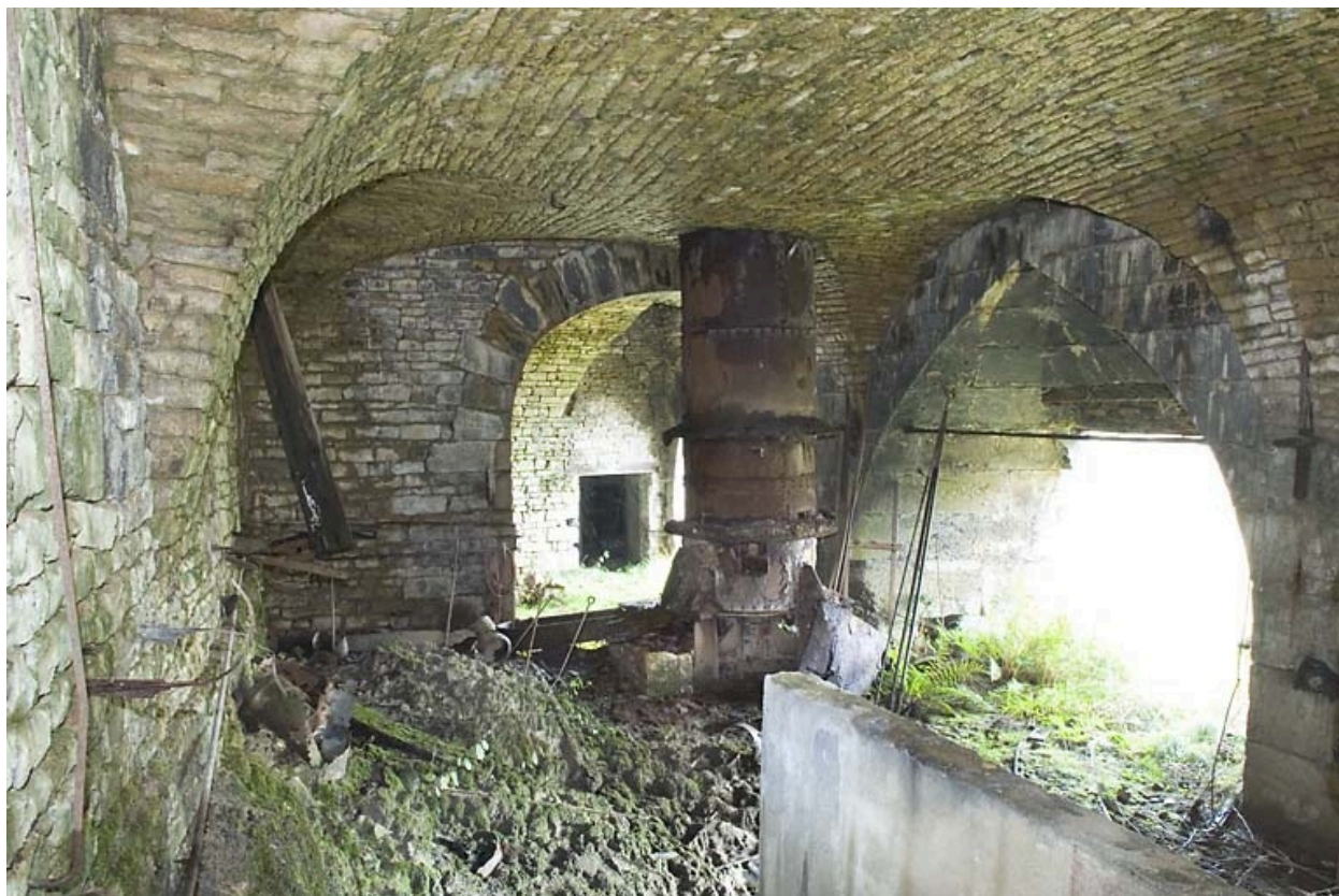
Salle des cubilots. Vue d'ensemble depuis le sud-est.
