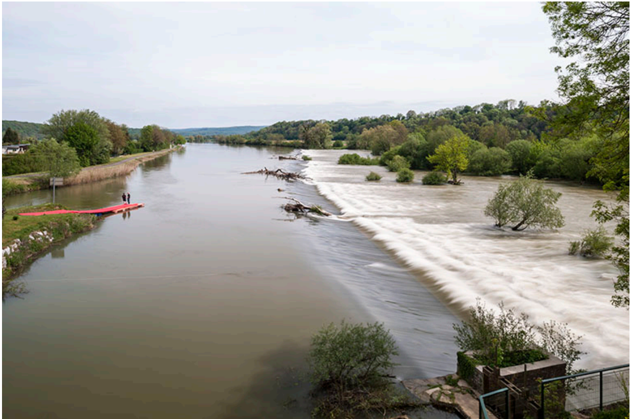
Le barrage, depuis l'ouest.
