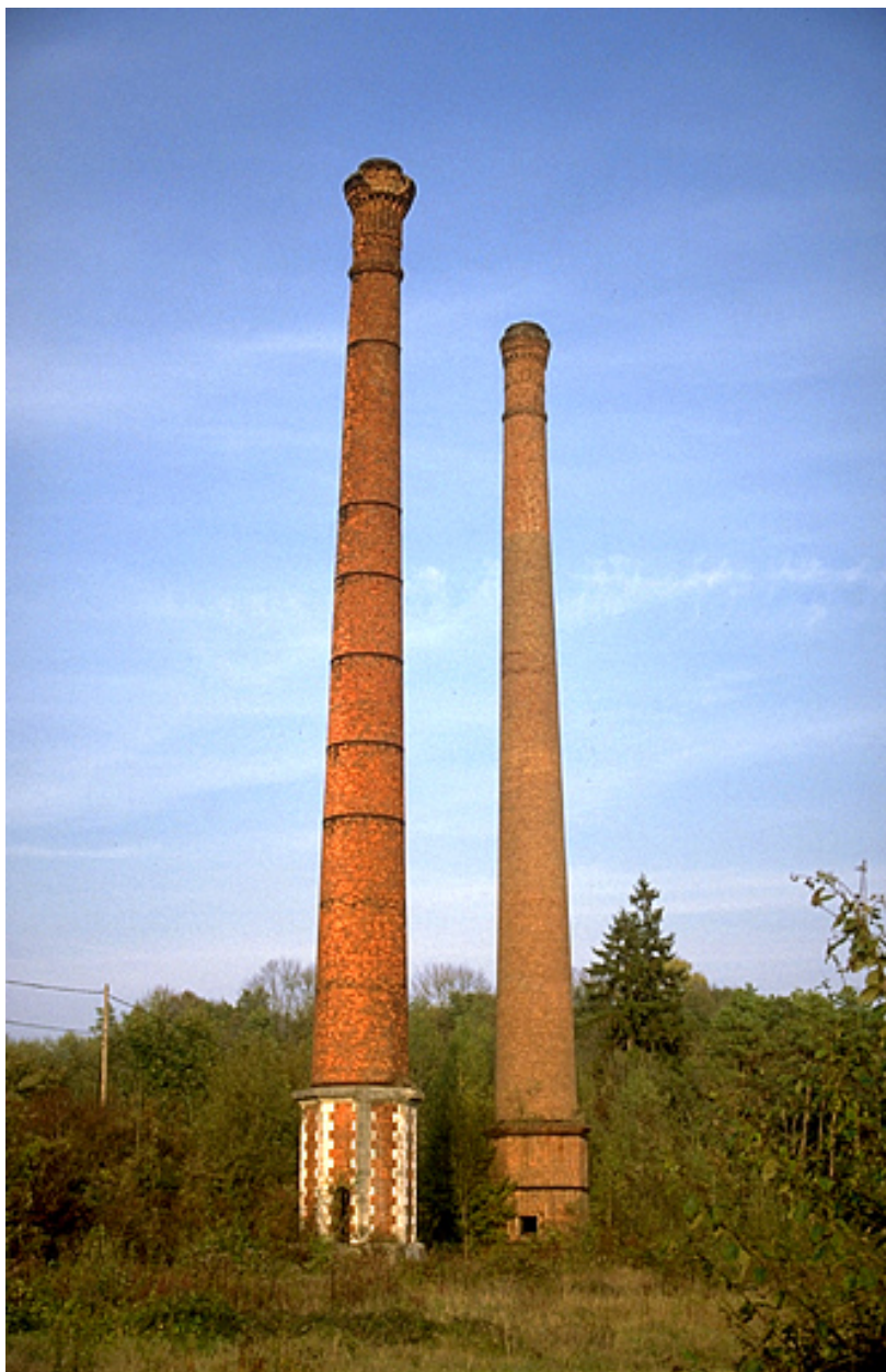
Cheminées d'usine, depuis le sud-ouest.
