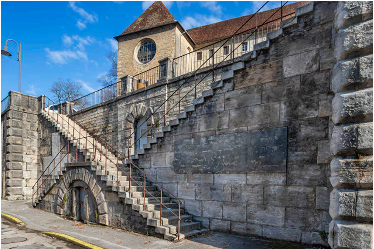
Façade sur la rue Charles Magnin, vue rapprochée de trois quarts : escalier.
