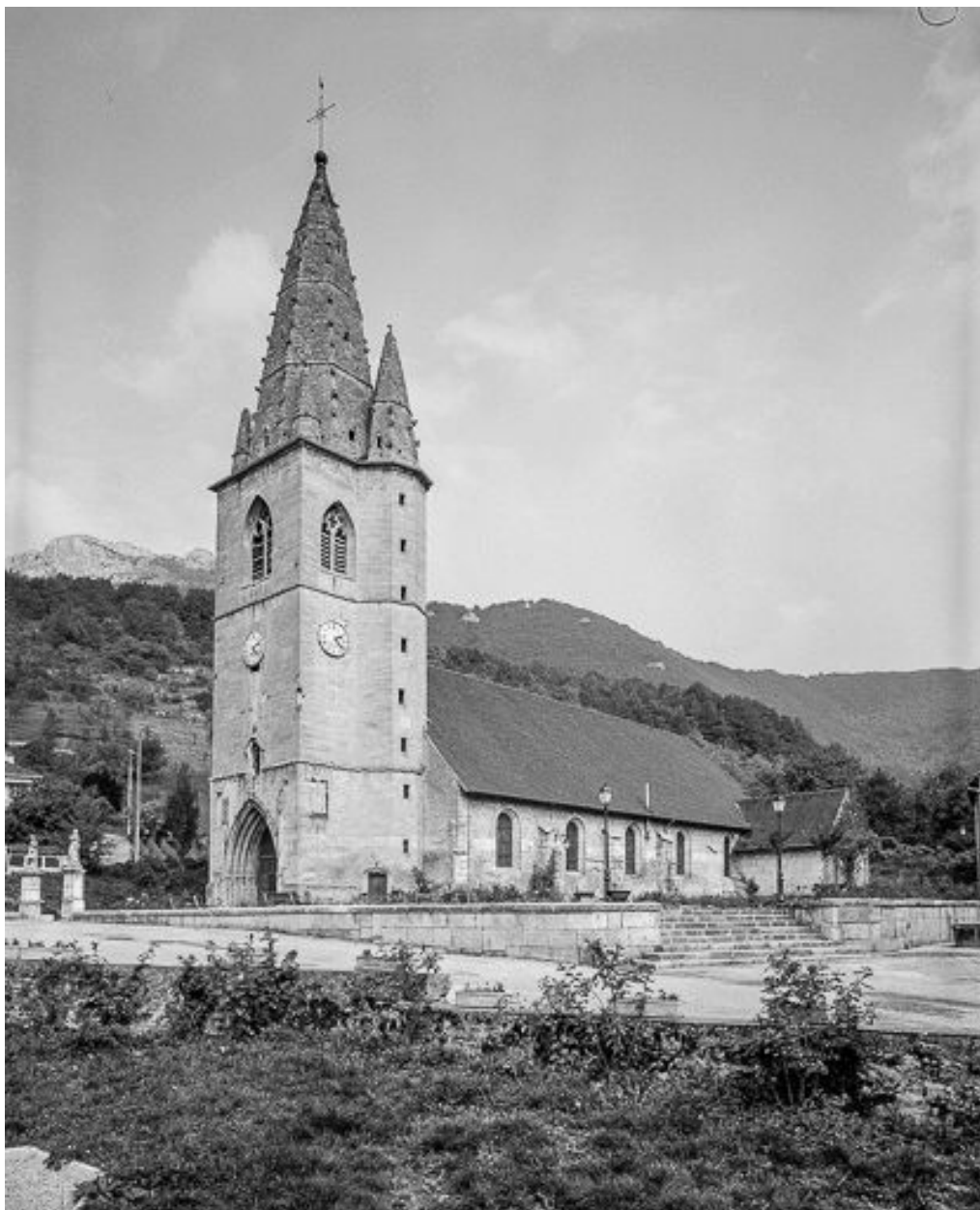
Façade antérieure et face latérale droite.
