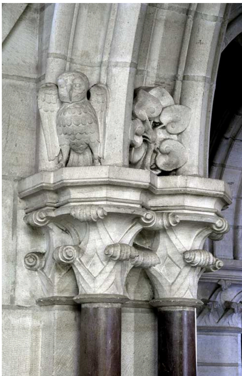
Bâtiment du réfectoire : réfectoire néo-gothique, décor sculpté.
