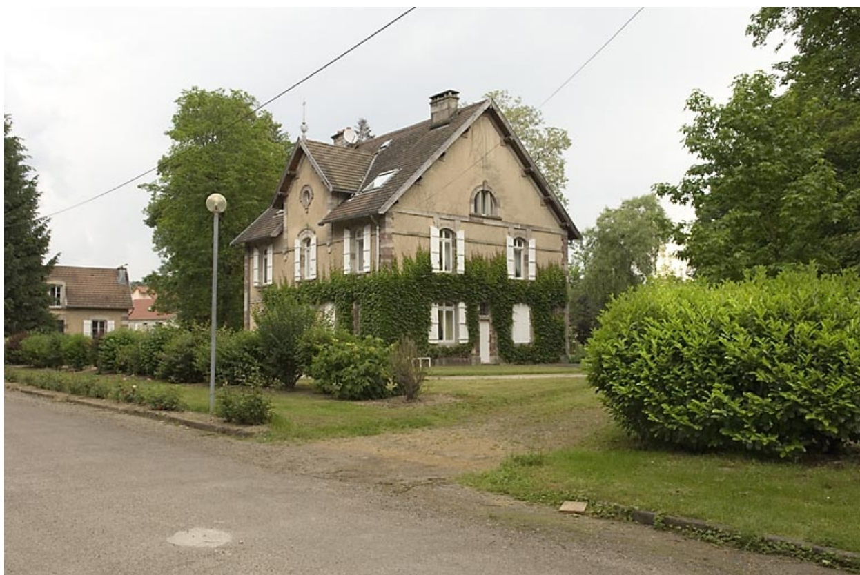
Logement (ancien chenil). Vue depuis le sud.
