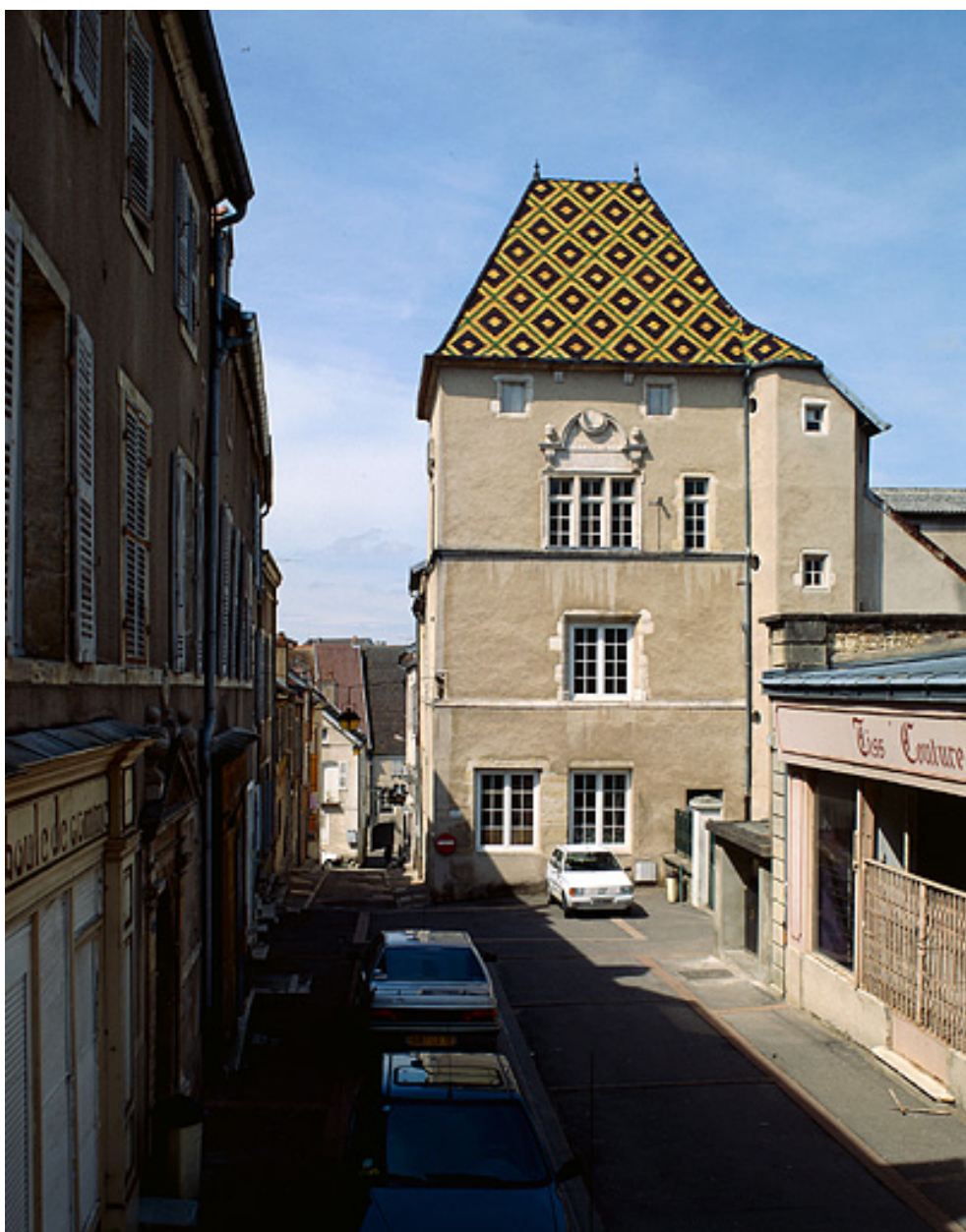
Maison située 12 rue des Terreaux.
