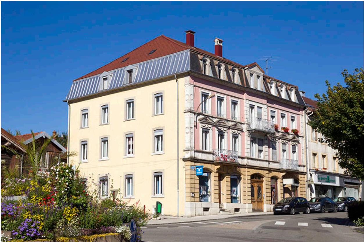
Immeuble et fabrique de montres Les Fils d'Edouard Wetzel puis Montres Thalès, à Morteau.
