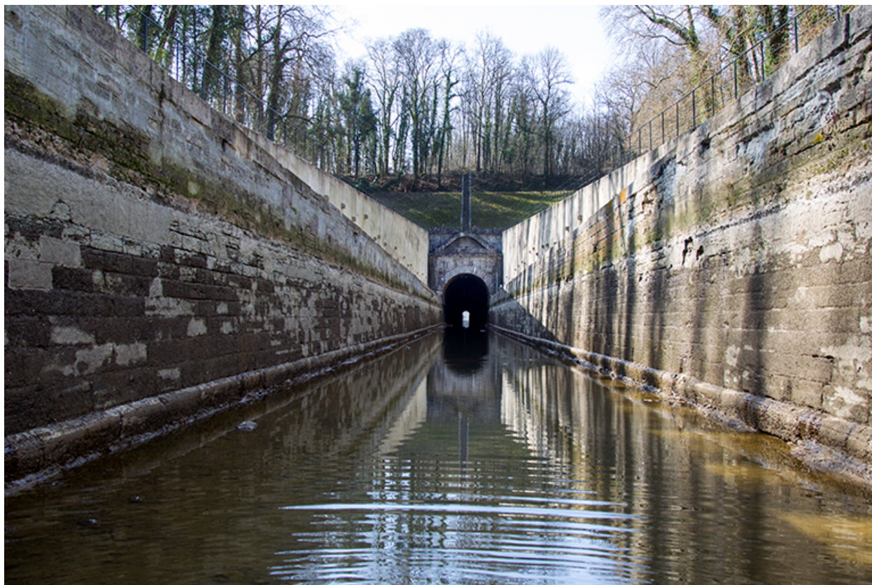
Le souterrain depuis la cuvette du canal.
