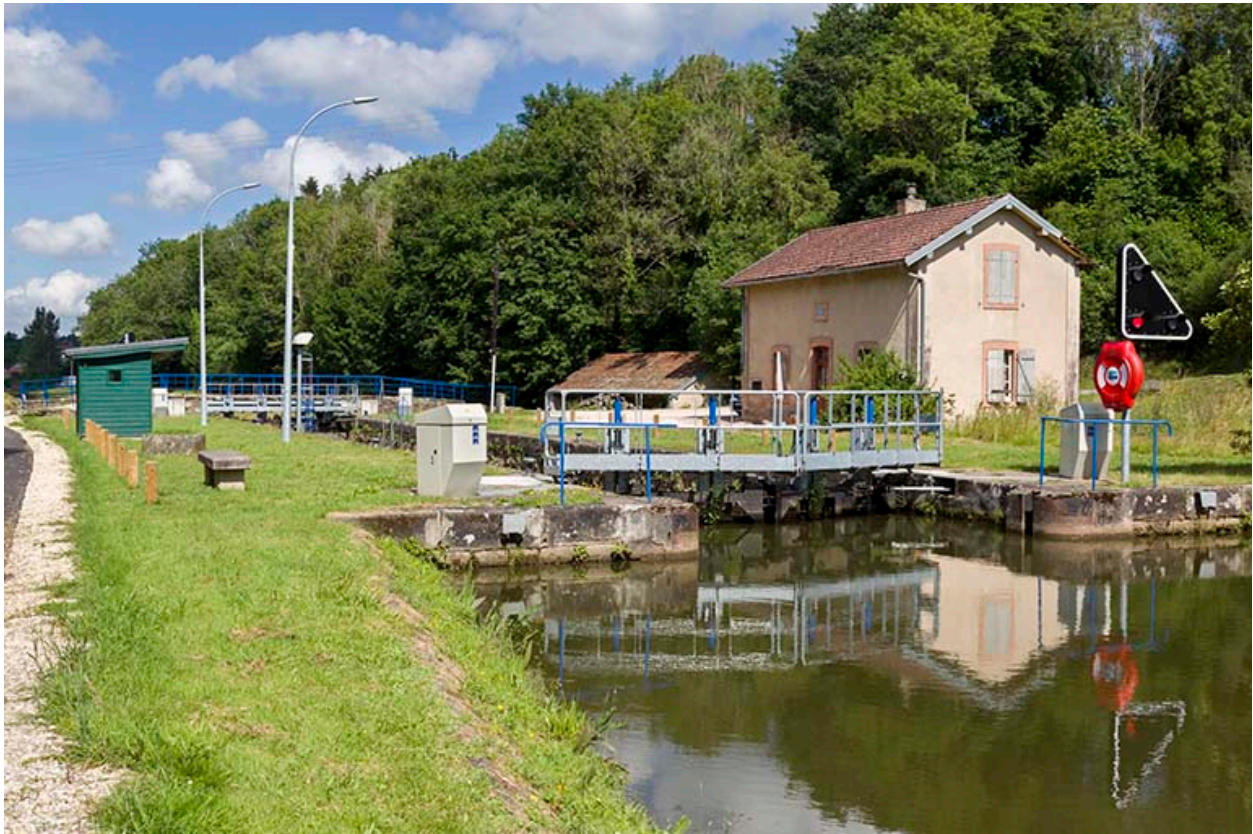
Le site d'écluse, depuis l'amont.
