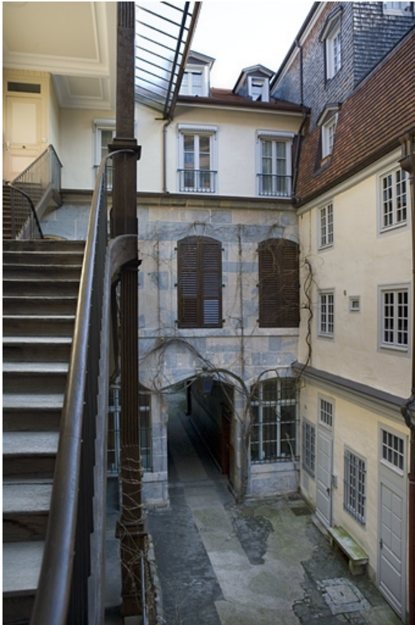
Façade du premier logis secondaire depuis l'escalier à cage ouverte.
