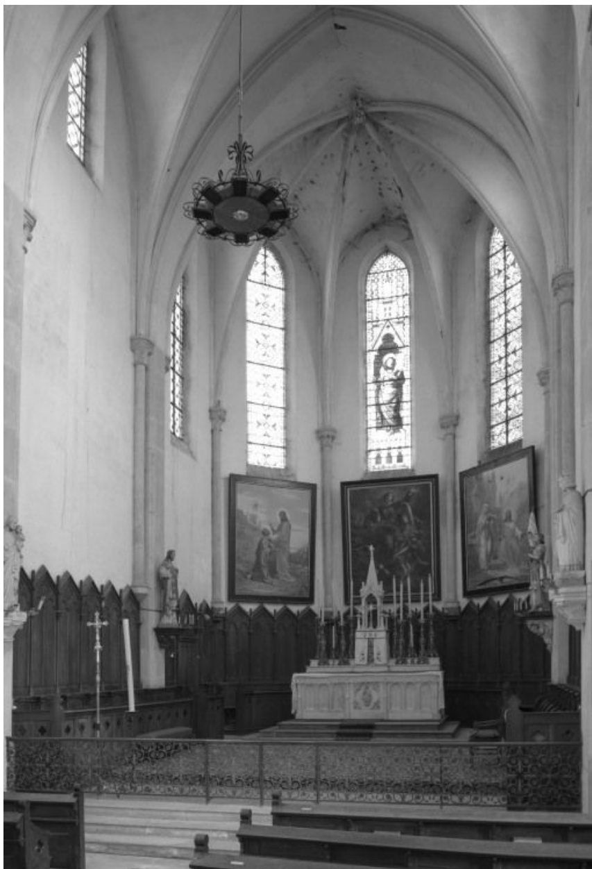
Vue intérieure du choeur
