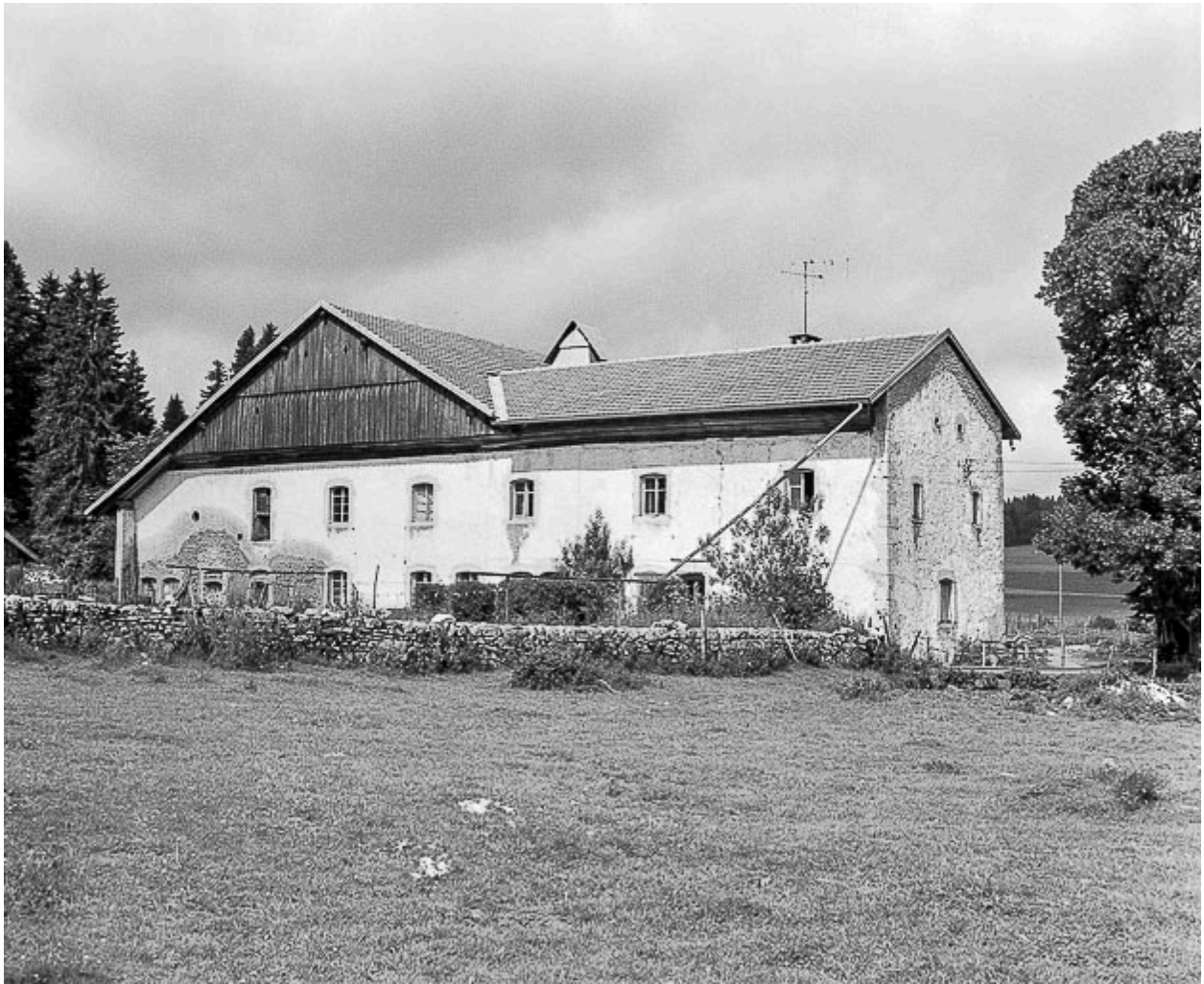
Façades antérieure et latérale droite.
