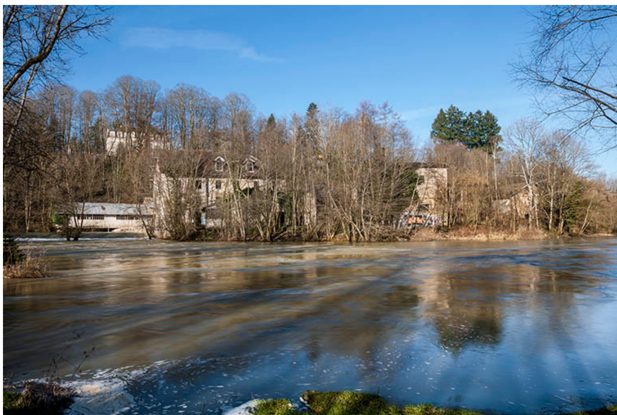
Vue d'ensemble depuis l'est (rive droite).
