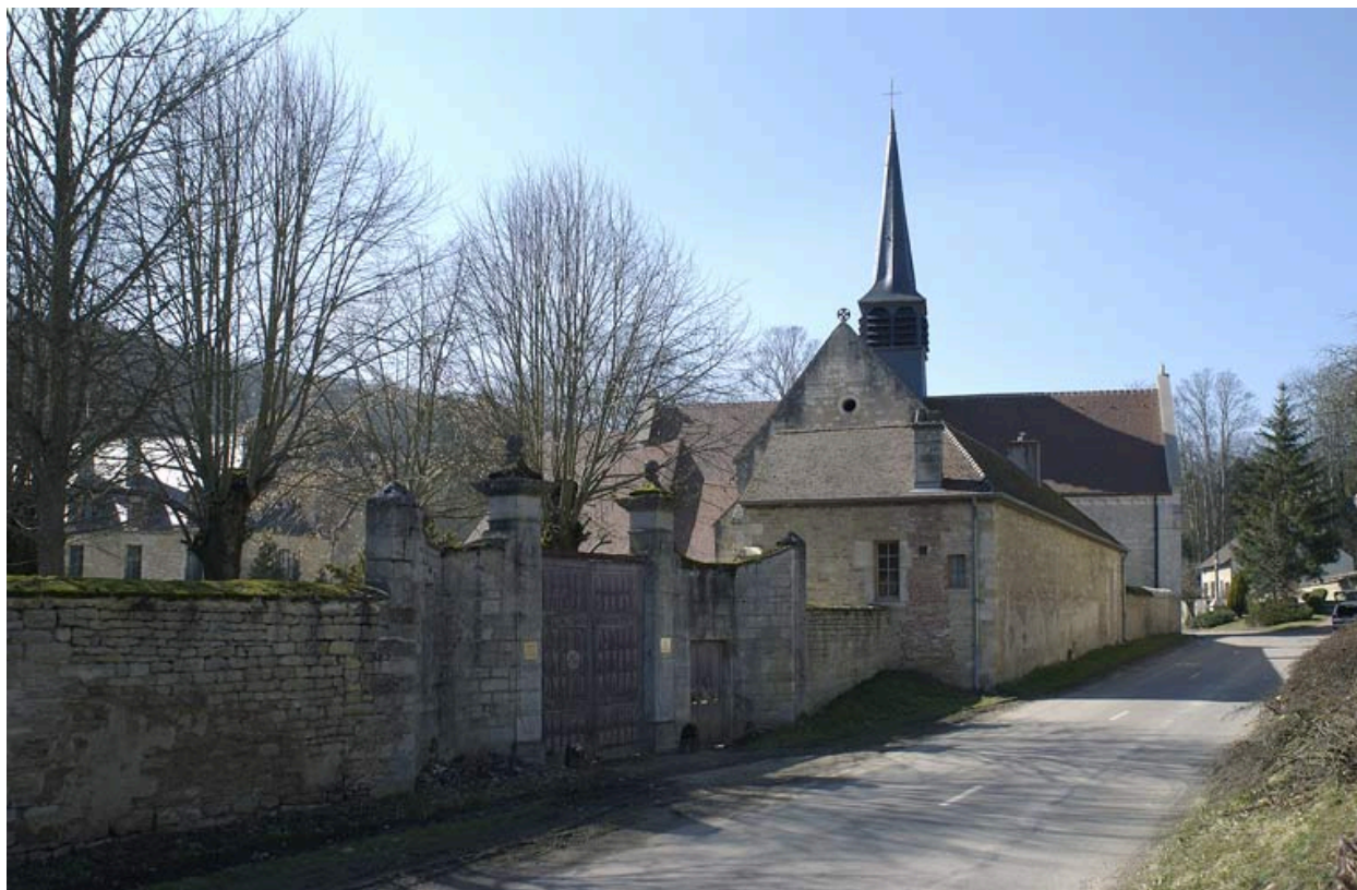
Mur de clôture nord et portail.
