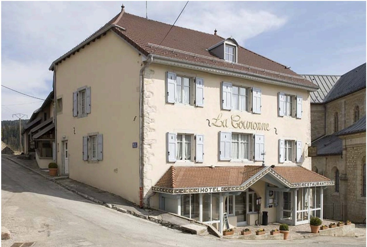
Façade antérieure et façade latérale gauche.
