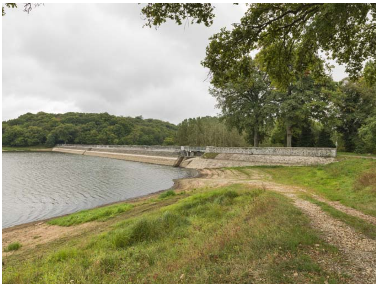
Vue de la digue.
