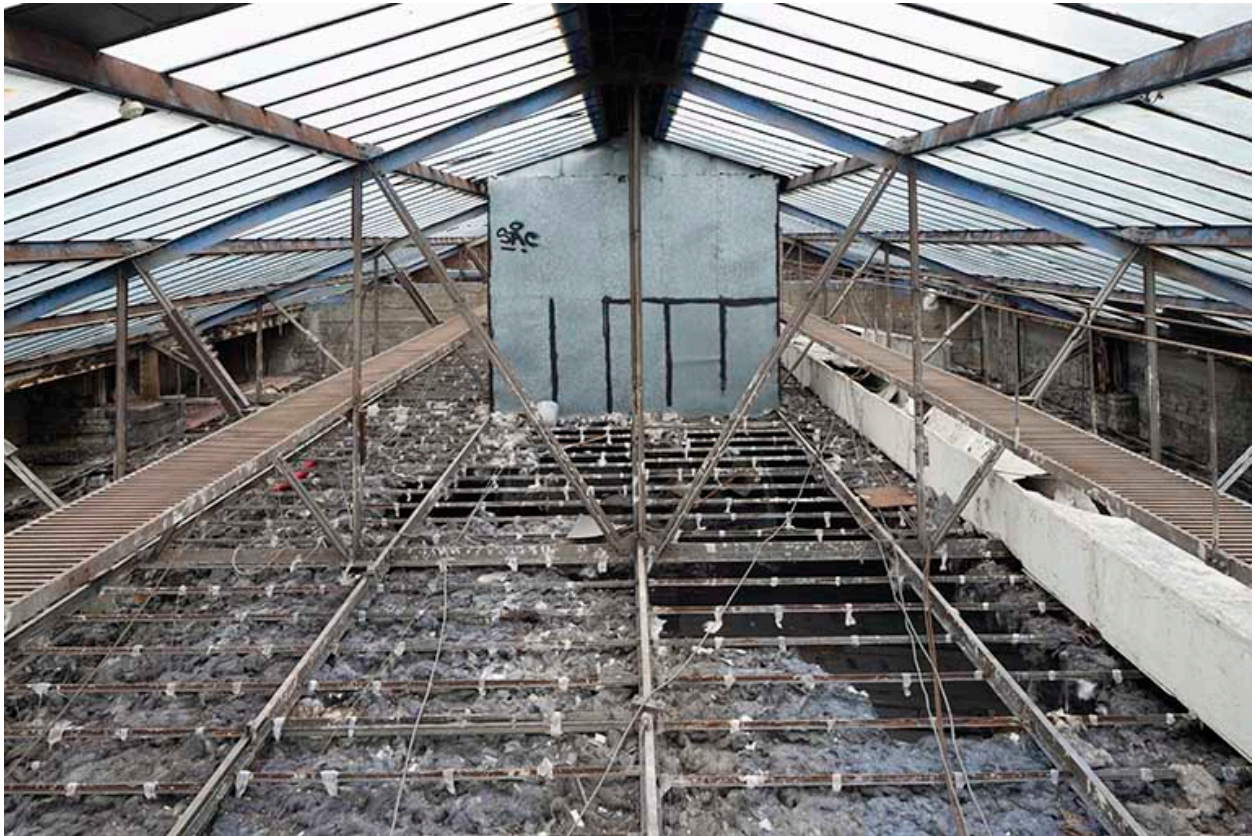
Halle : charpente métallique et verrière.
