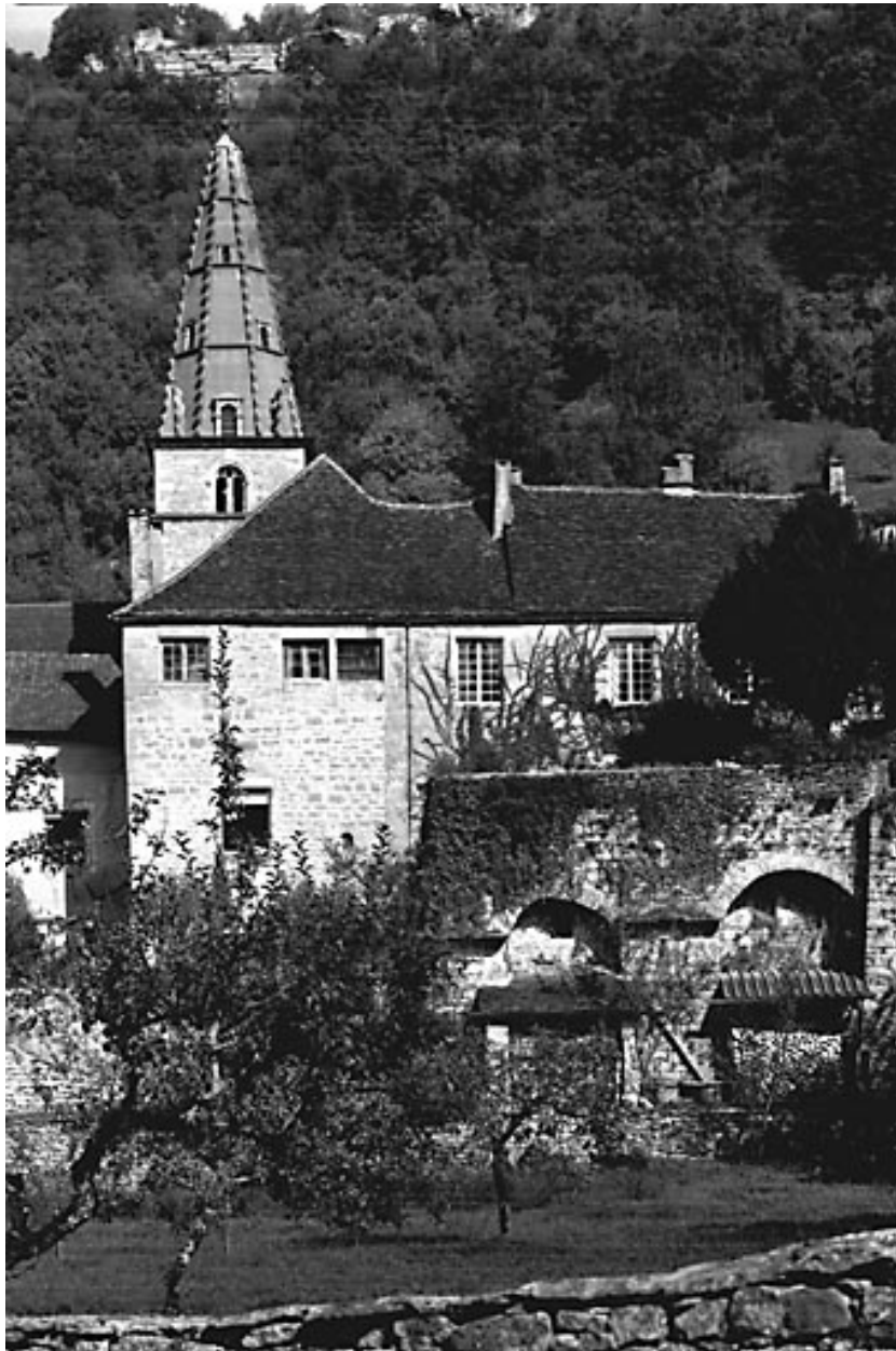
Face sud des bâtiments à l'est du cloître.
