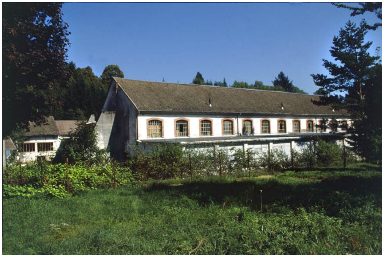
Façade occidentale de la salle de tissage.
