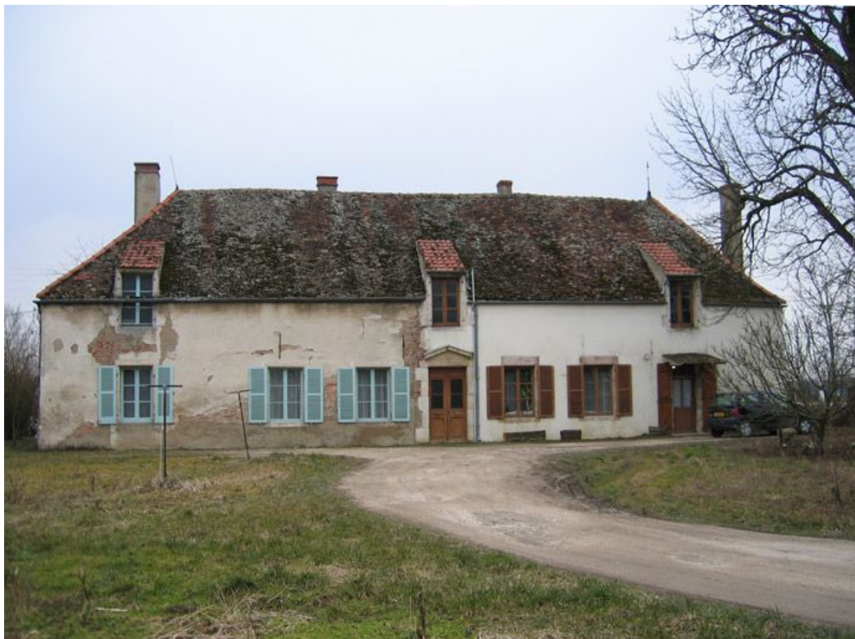
Vue d'ensemble de la façade.
