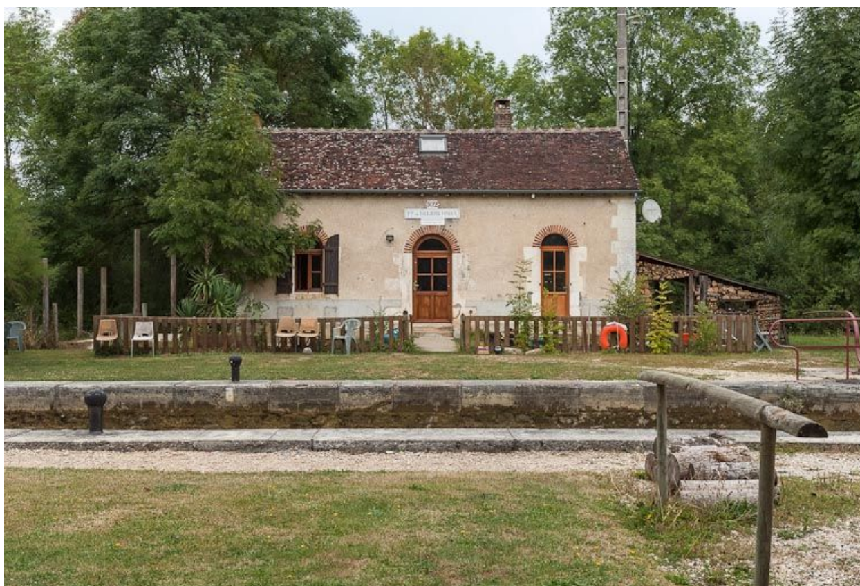
Maison éclusière de face.
