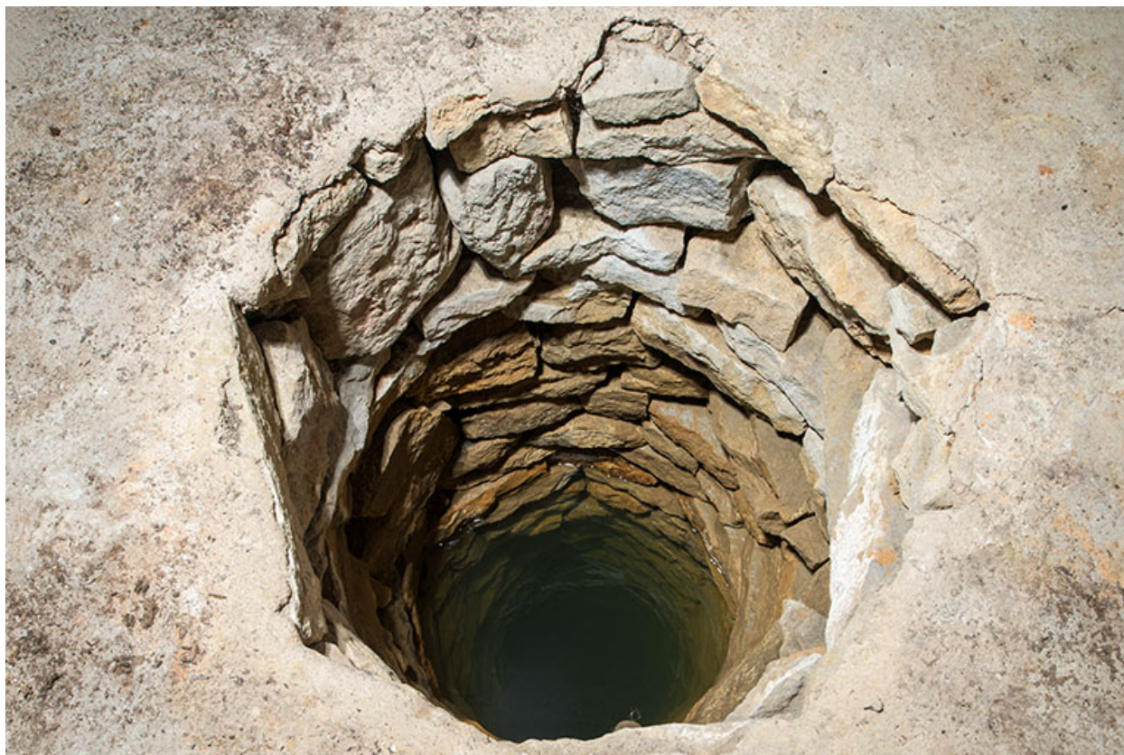
L'intérieur du puits.
