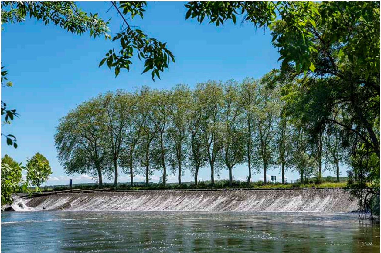
Déversoir en amont du barrage.
