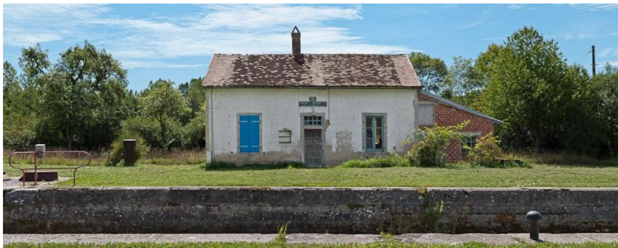
Vue de face de la maison éclusière.
