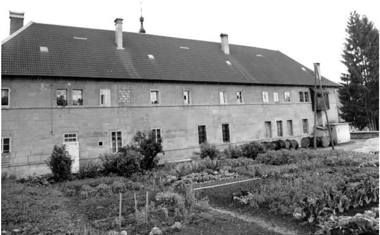
Extérieur : façade sud.
