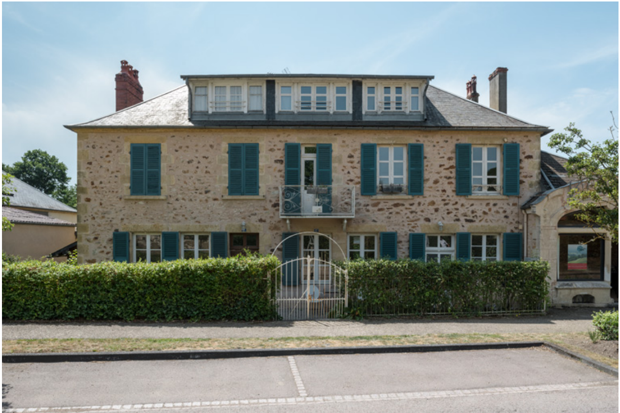
Façade actuelle sur l'avenue, vue de face.
