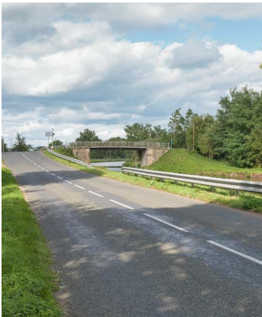
Vue d'ensemble du pont.
