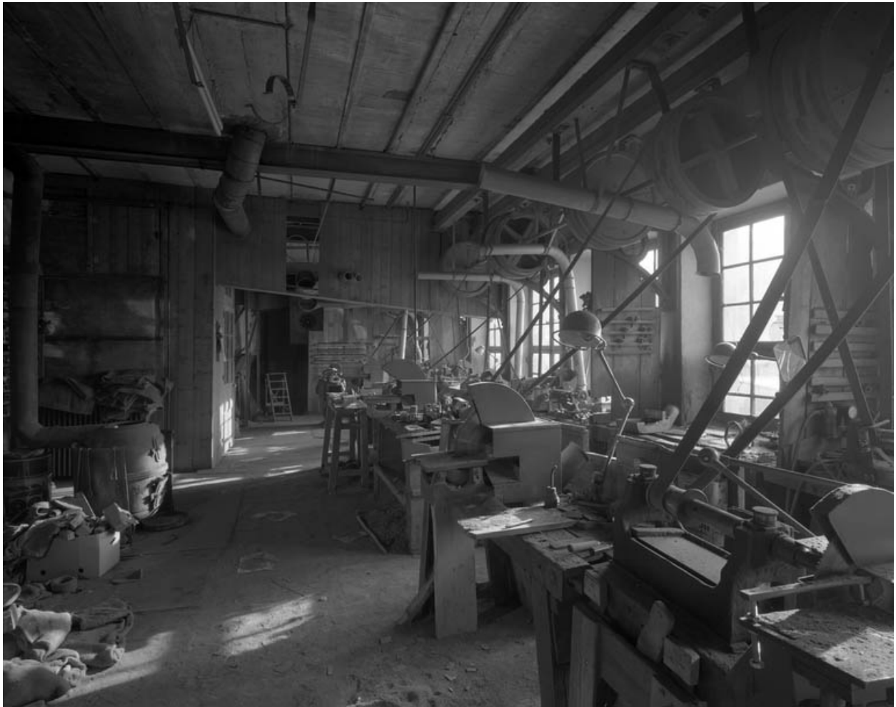
Intérieur de l'atelier d'ébauchage, depuis l'entrée.
