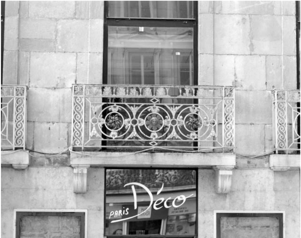
Façade sur rue, détail du balcon de la partie droite.
