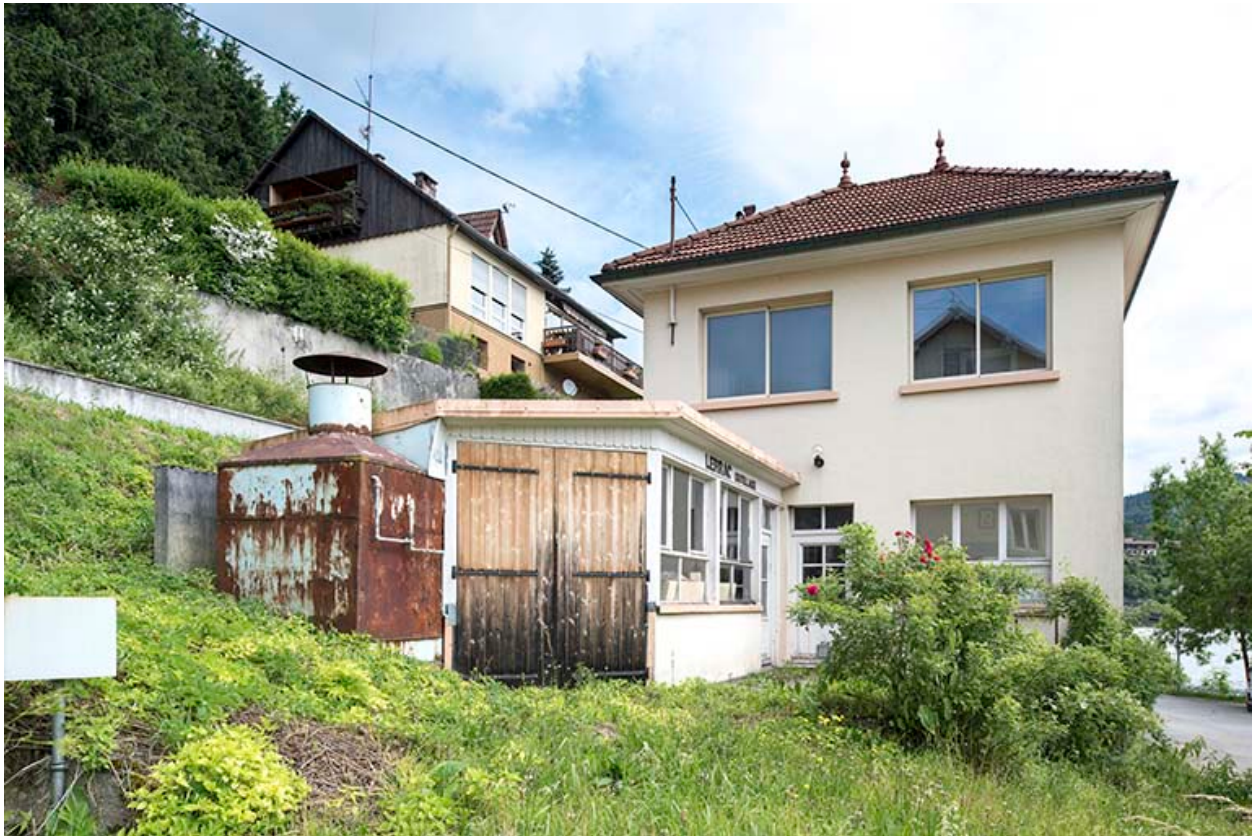
Façade latérale droite et atelier de peinture.
