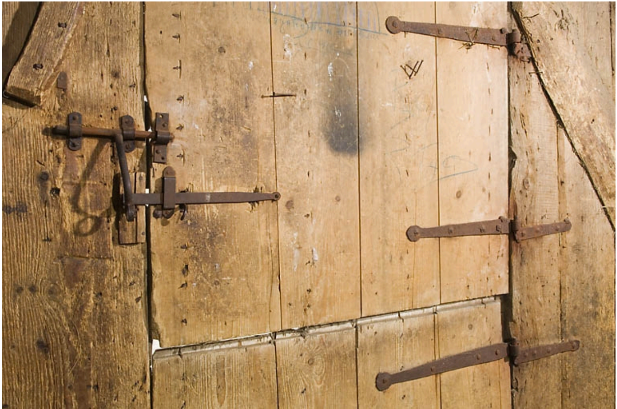
Façade antérieure, porte de grange : fermeture.
