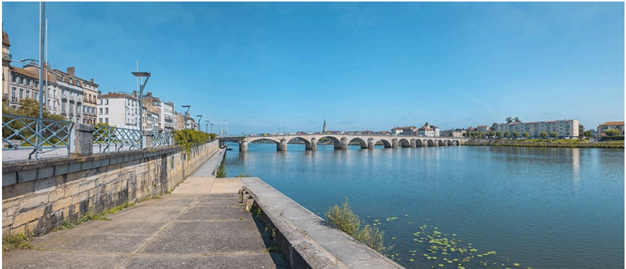
Vue d'ensemble du pont, d'aval et depuis la rive droite.
