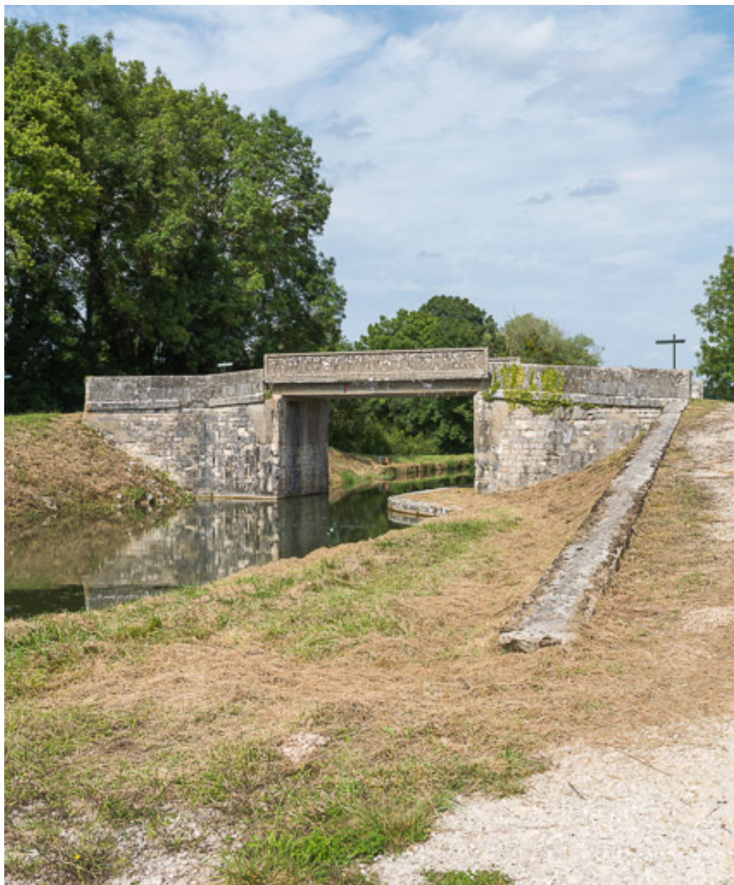
Vue du pont.
