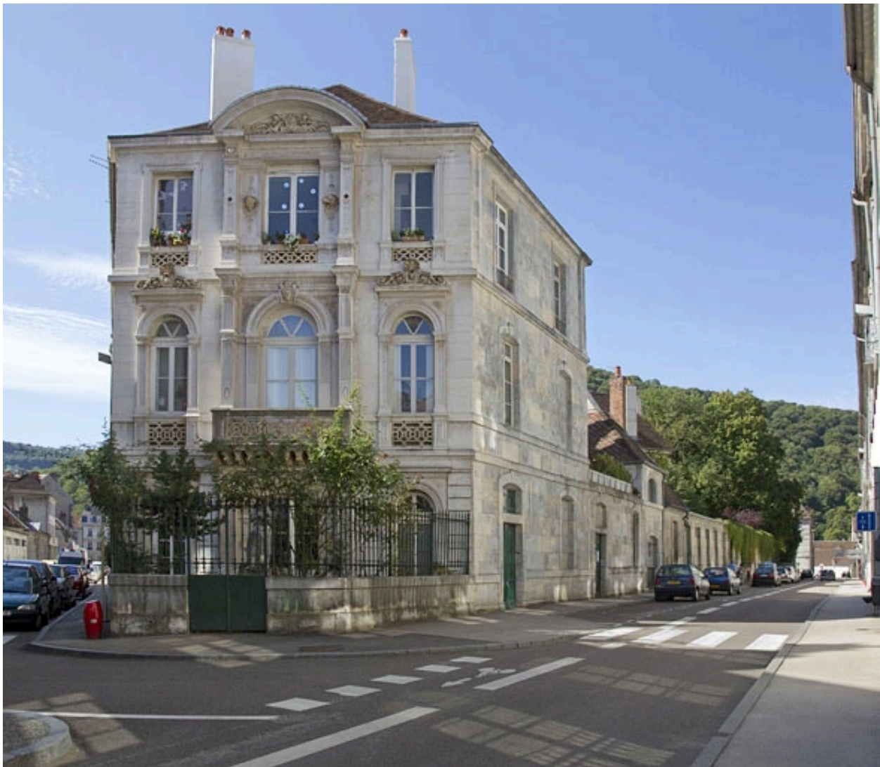
Vue d'ensemble depuis l'angle de la rue Chifflet.
