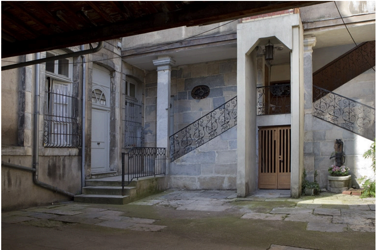
Vue du départ de l'escalier en fond de cour, de trois quarts droit.
