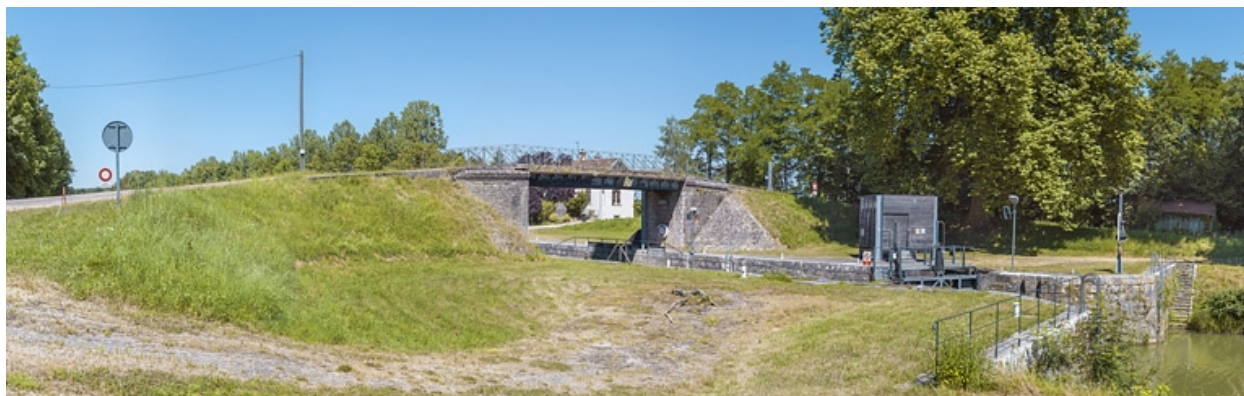
Vue d'ensemble du site d'écluse.
