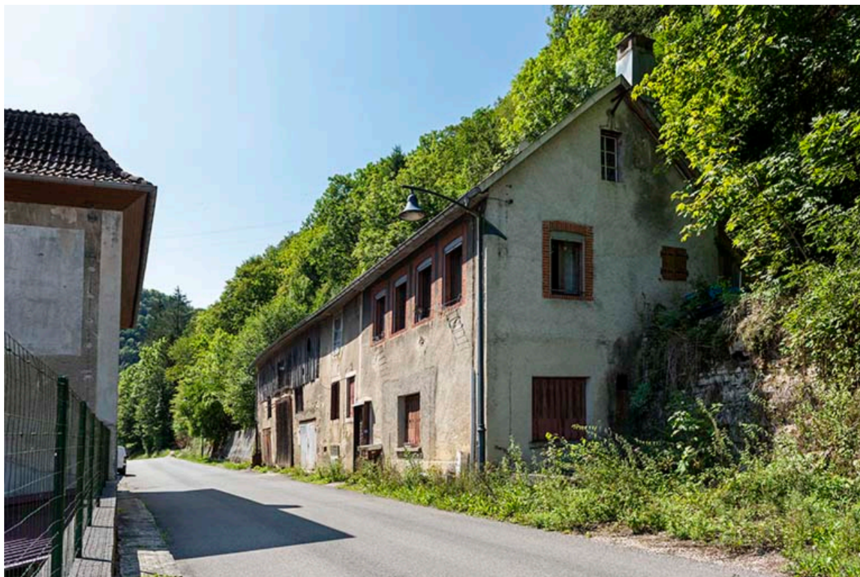
Logement occidental : vue d'ensemble, depuis le nord.
